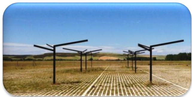
Al no necesitar drenaje subyacente ni bordillos perimetrales, los aparcamientos de **Césped armado Paviprint®** se pueden ampliar sin tener que preocuparse de desniveles para el drenaje
