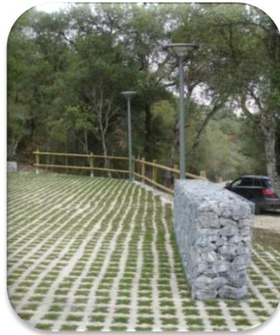
Césped armado Paviprint®" se puede utilizar para la construcción de vías de acceso para vehículos de gran tonelaje como pueden ser bomberos, servicios de emergencia y camiones de mantenimiento forestales, como para plataformas de aterrizaje y despegue de helicópteros ya que el sistema aguanta las cargas perfectamente.
