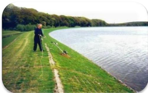
Por todo esto en el caso de descenso de olas o de una disminución rápida de los niveles de agua se origina la rápida descarga de las presiones hidrostáticas, lo que hace que de esta forma la presión residual en el subsuelo no deforma al "Césped armado Paviprint®", lo que podría ocurrir con otros sistemas.
