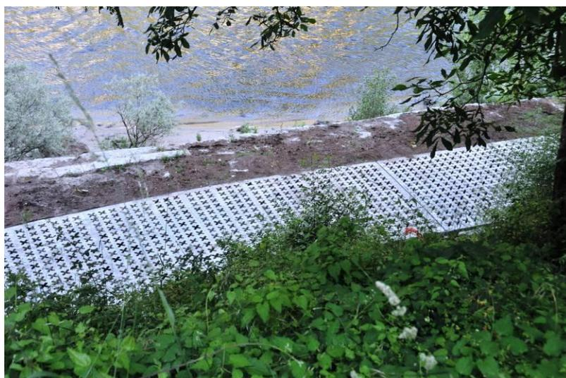
En estos 600 ml de longitud de senda peatonal se ha querido incorporar un pavimento permeable que permita crecer la hierba y a su vez que pudiese soportar el tráfico de los vehículos de mantenimiento y urgencias, además de servir para la colocación de balizas bajas estancas para la colocación de luz pública.
